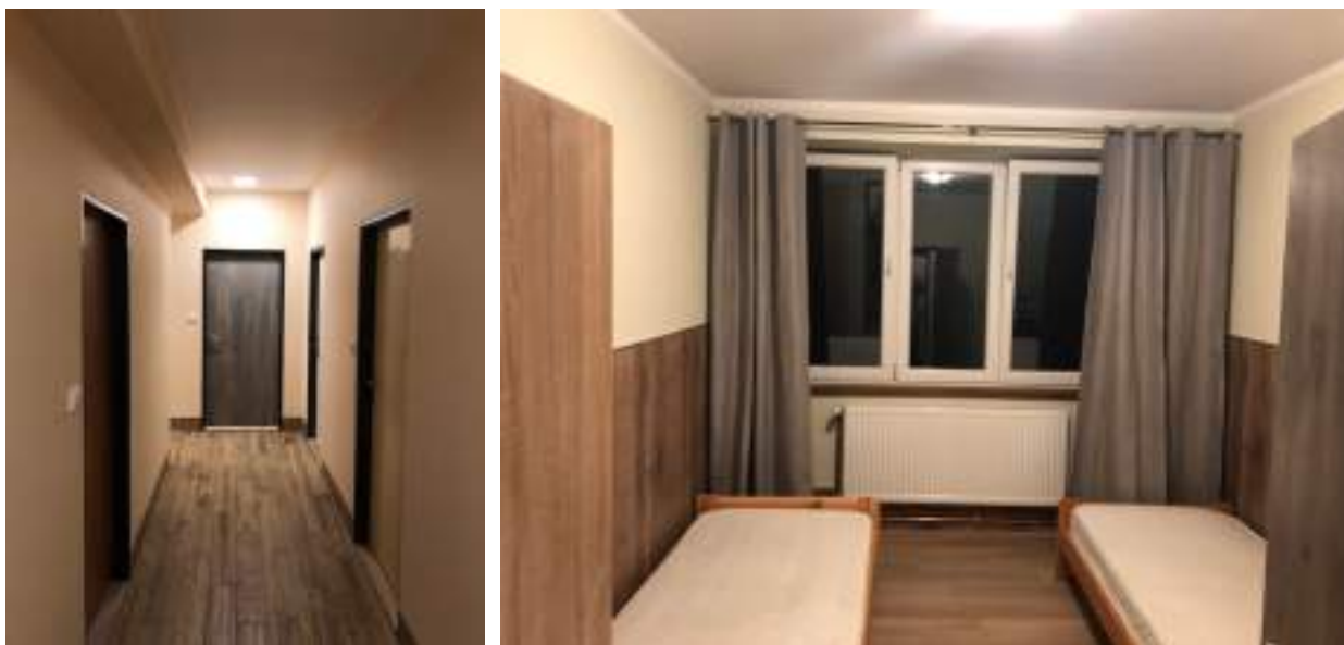
Rekonstruovaná chodba a pokoj
